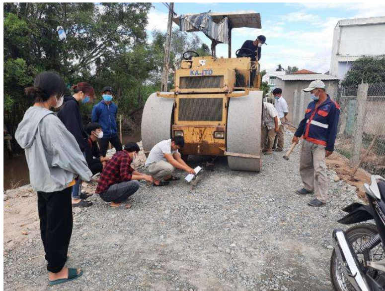
Hình 2. Sinh viên MTU Khóa 18 tham quan thi công tại công trình đường Khóm 4-5, Phường 8, TP Vĩnh long (2019)
