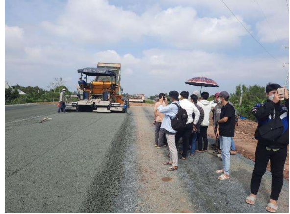
b) SV MTU xem đang rải đá cấp phối bằng xe chuyên dụng.
