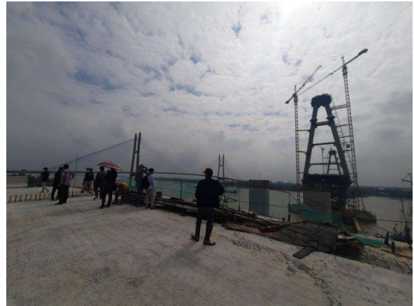
b) SV MTU xem thi công trụ cầu Mỹ Thuận 2
